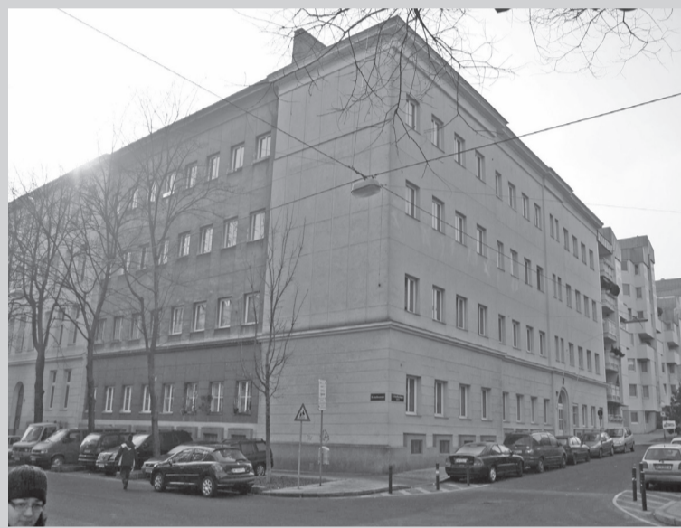
2 nach Sanierung – Straßenfassade
